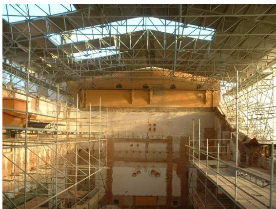
Plenarsaal auf den Rohbau zurückgeführt
