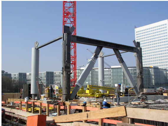
Zweigeschossige Stützen eines Aussteifungsgerüsts
