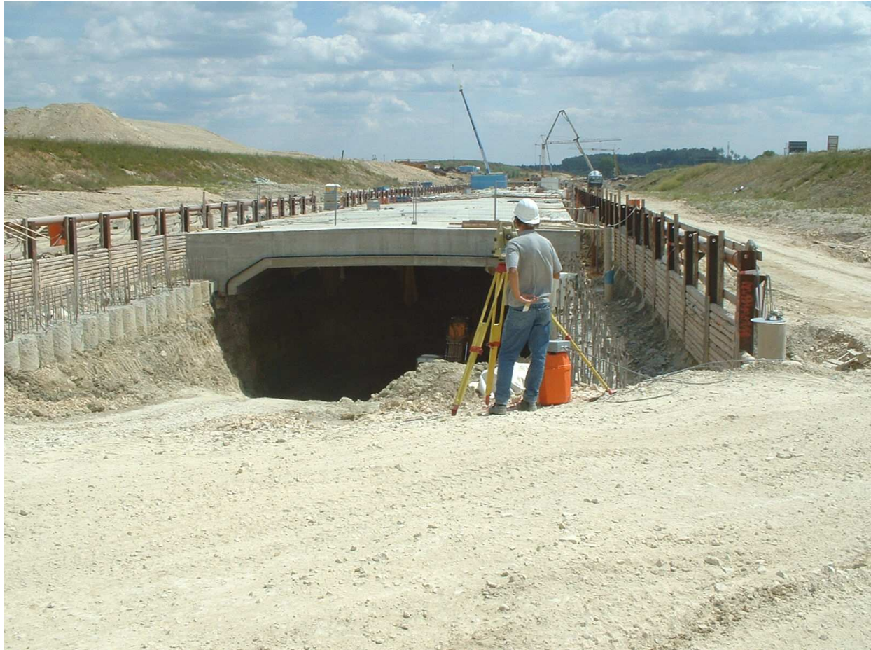
Tunnel E2, Denkendorf
