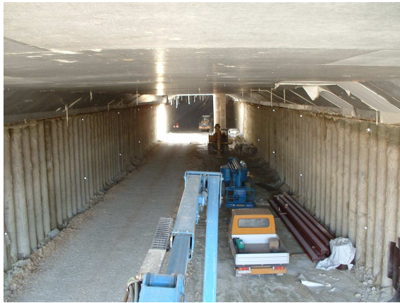
Meßprismen an Bohrpfehlwänden, 1. Aushubniveau
